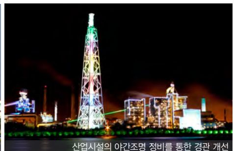
산업시설의 야간조명 정비를 통한 경관 개선
