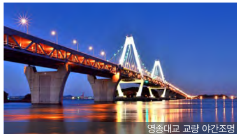
영종대교 교량 야간조명
