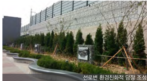
선로변 환경친화적 담장 조성
