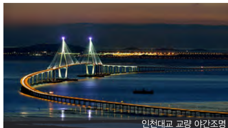
인천대교 교량 야간조명
