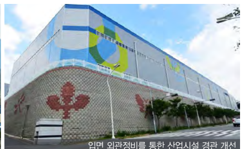
입면 외관정비를 통한 산업시설 경관 개선
