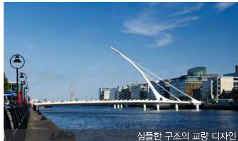
심플한 구조의 교량 디자인
