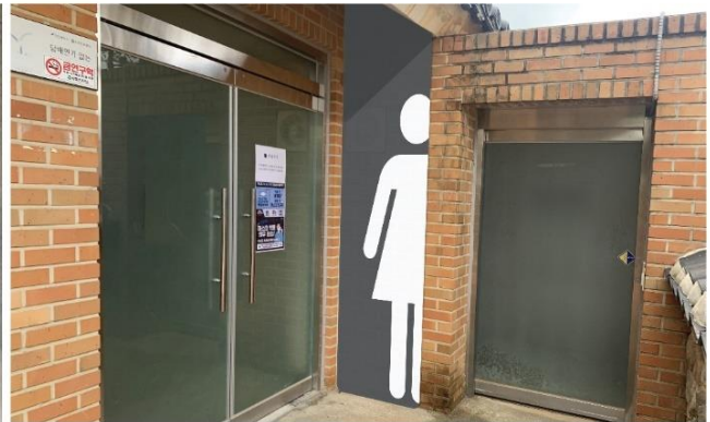
- 화장실 출입문 측면 적용
